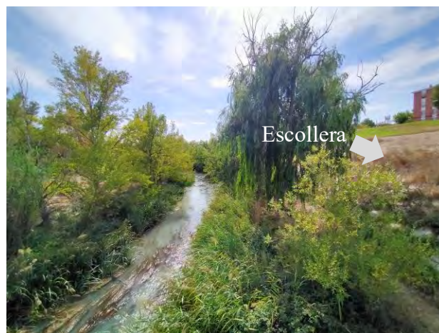
Continúa esollera en Parque fluvial Zuera, tramo 2
