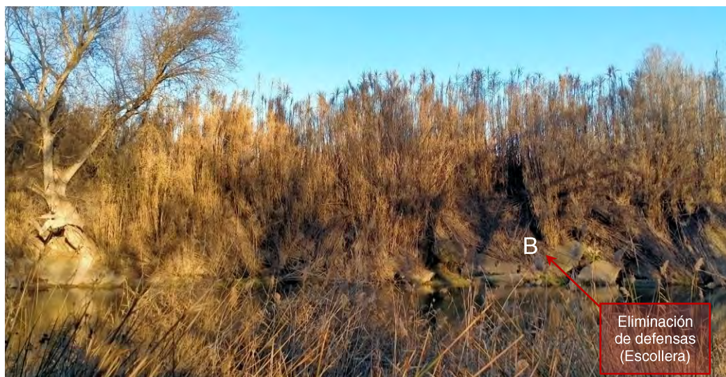
Figura 46. Escollera en margen izquierda, zona del parque fluvial. Fuente: fotografía de la autora (4/2/23).
